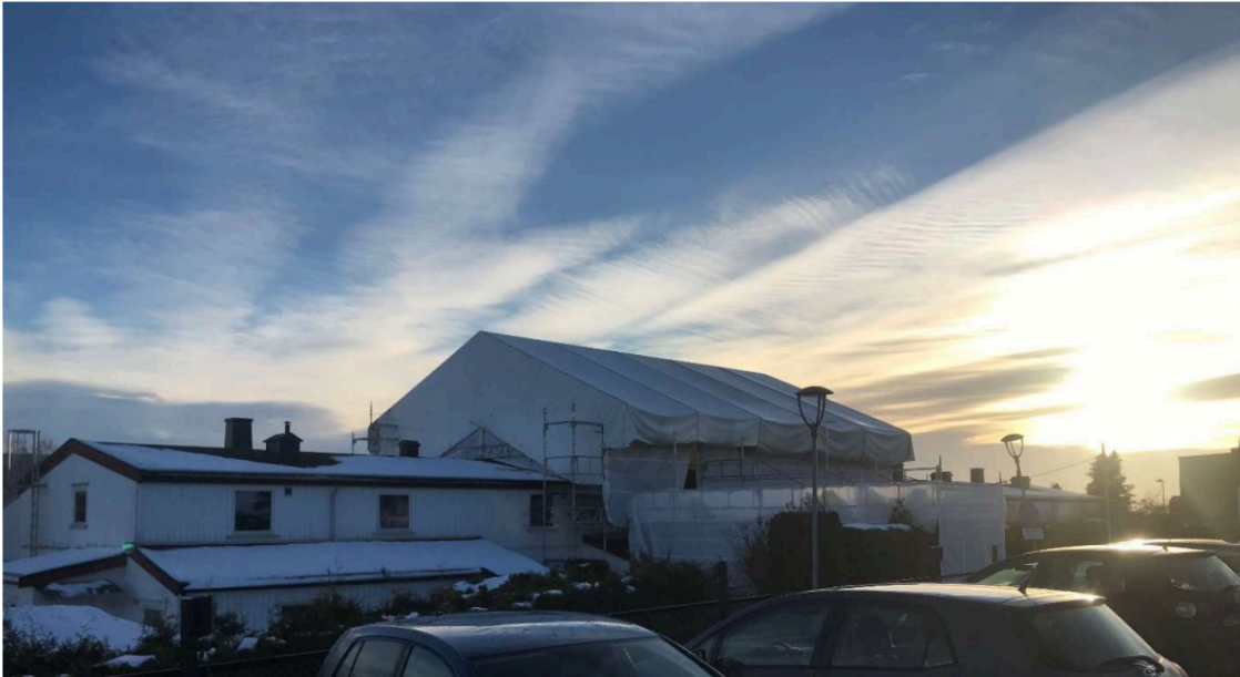
Bilde 1: Veitvetsvingen 3, stillas og tak over tak.
