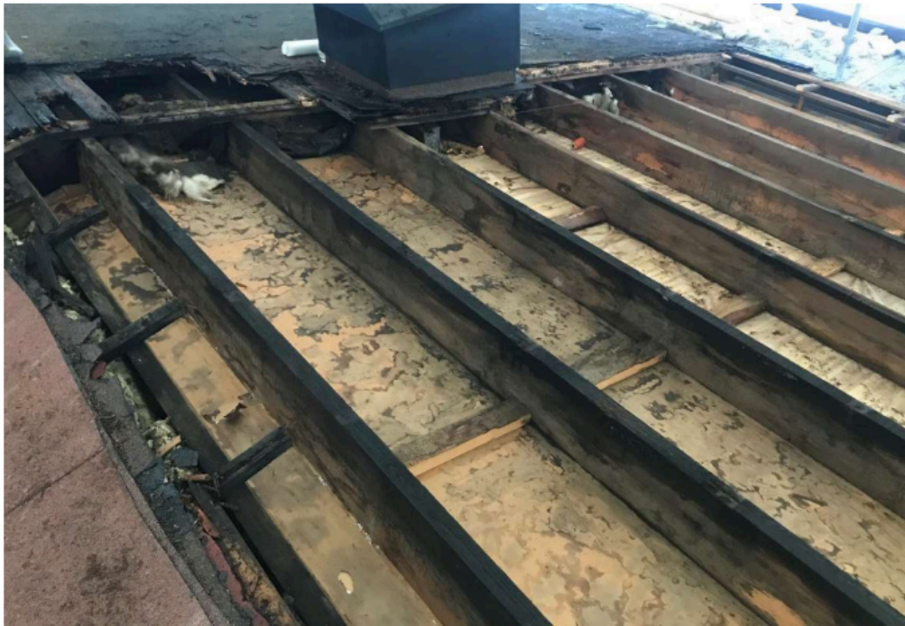
Bilde 3: VS 3h, innvendig himling er skiftet på nedre del
