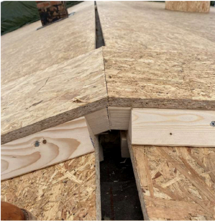
Bilde 11: SV 3h, taktro og åpning for lufting.
