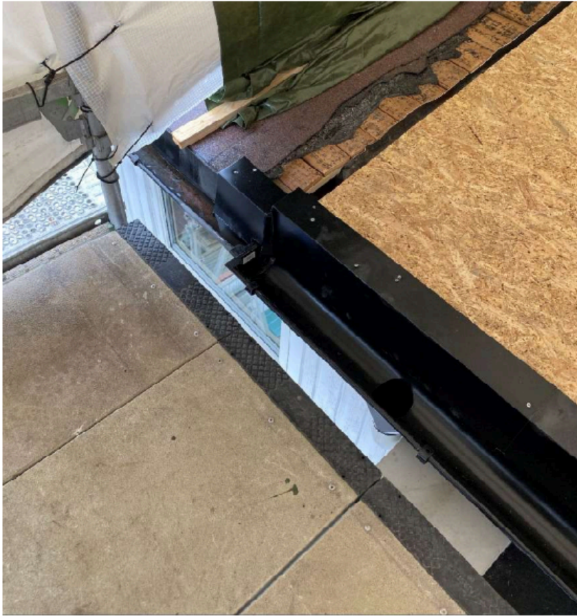
Bilde 13: VS 3h, takrenne og forkantbeslag.
