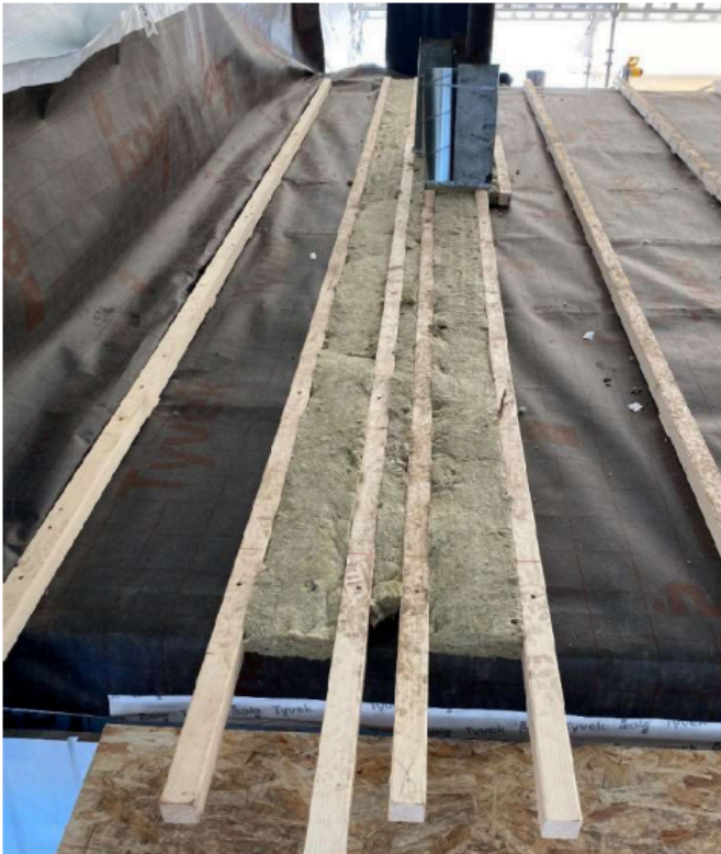
Bilde 10: VS 3, vindsperre og branntetting over skillevegg.
