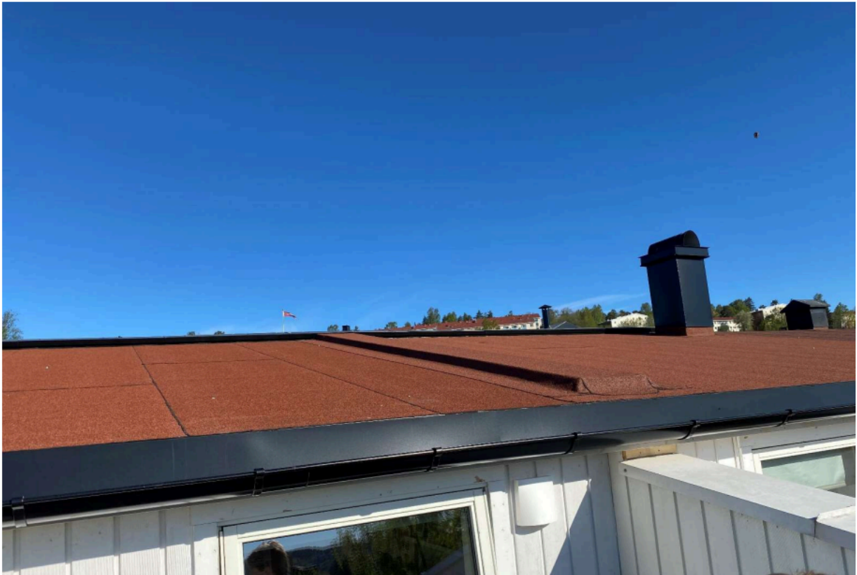
Bilde 15: VS 3, takteking, luftelyre møne, pipebeslag og ventilasjonshatt.
