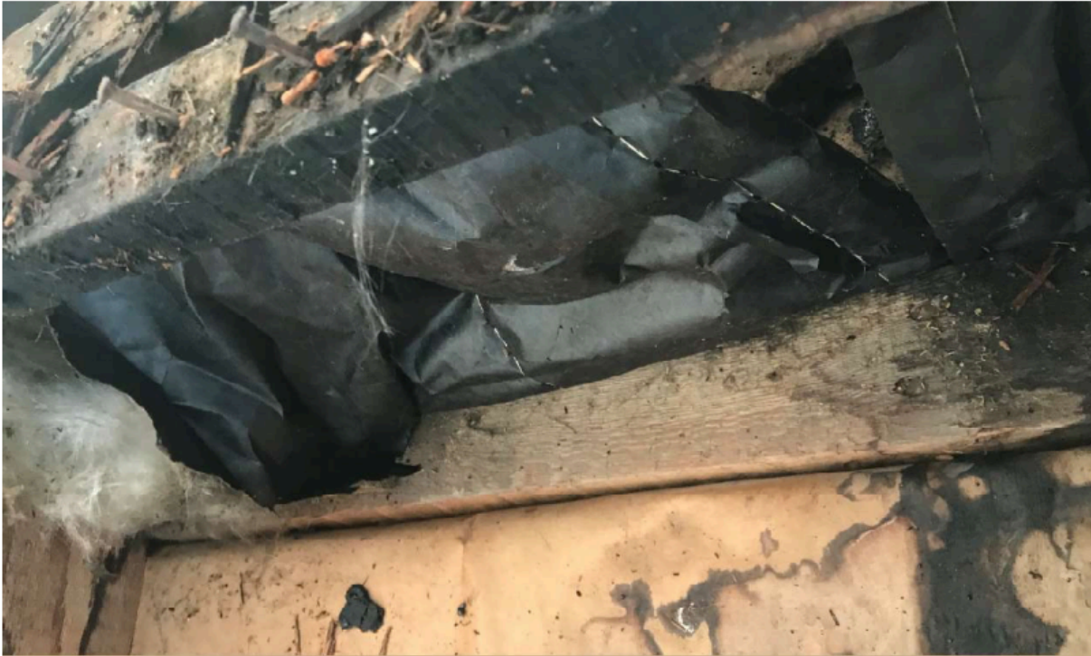
Bilde 5: VS 3h, sydd matte mellom 3 toms bære/skillevegg.
