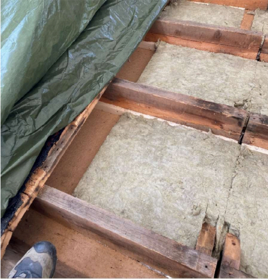
Bilde 7: VS 3, isolering med 50 mm under dampsperre.
