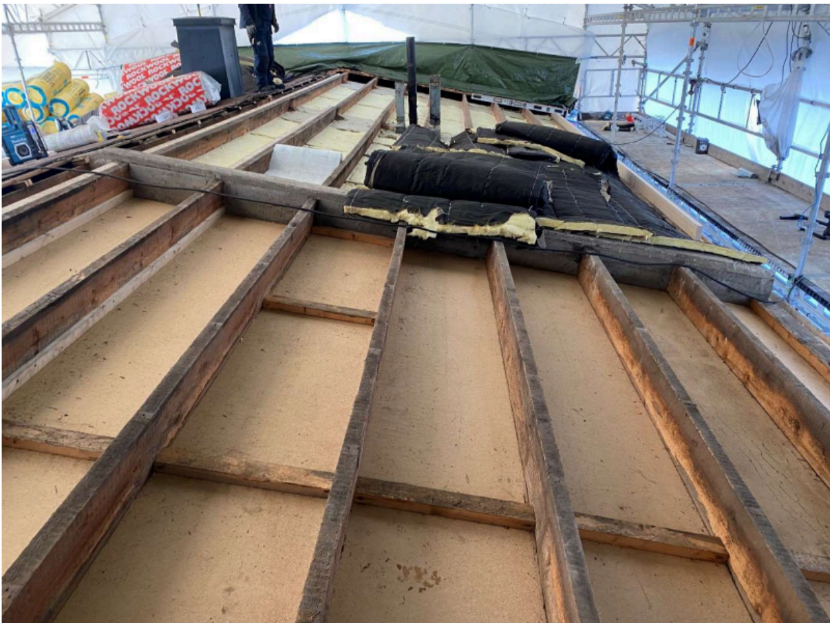
Bilde 6: VS 3h, isolering med 50 mm er utført på h.
