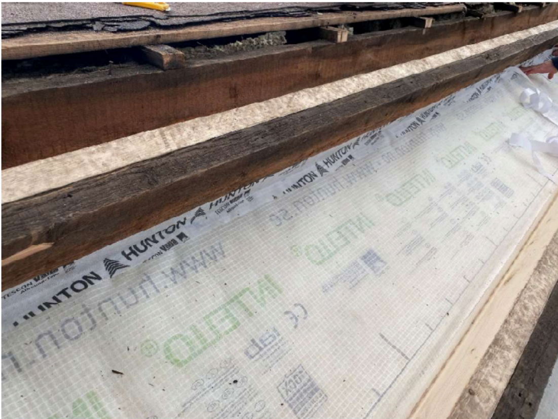
Bilde 8: VS 3, dampsperre.
