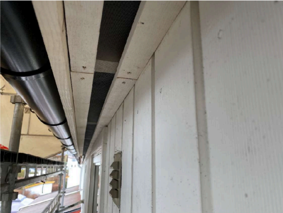
Bilde 14: VS 3h, gesims med lufting.
