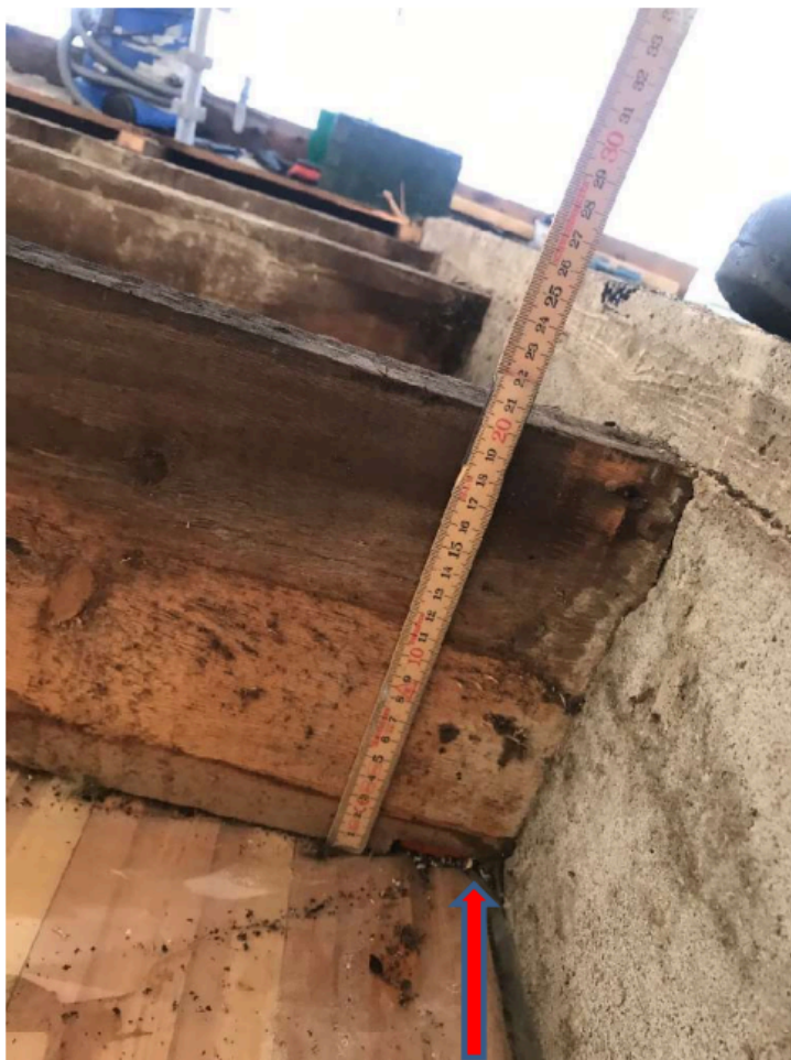
Bilde 4: VS 3h, takås lagt an på stålvegg i betongvegg
